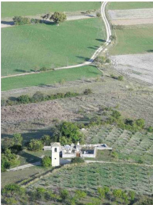
Le clocher isolé et le cimetière de l'ancienne église Saint-Arey au quartier appelé Le Prieuré ou La Paroisse
