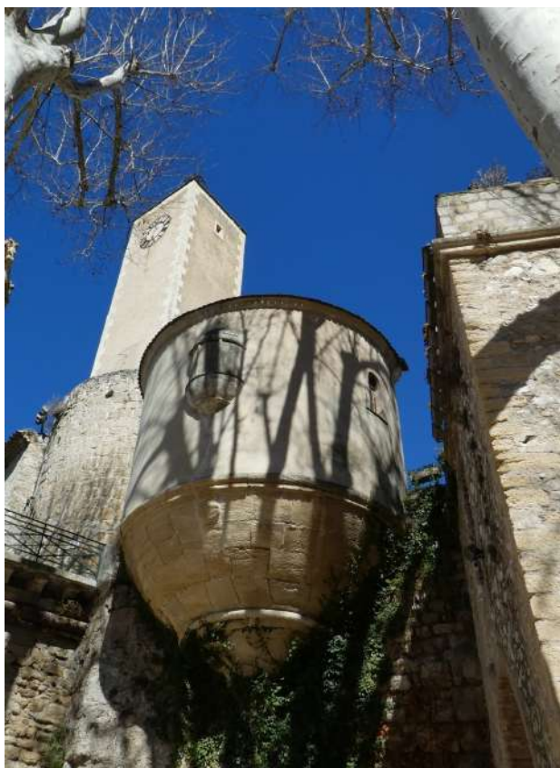
Photo prise du lit de l'Ouvèze, en contrebas de la chapelle
