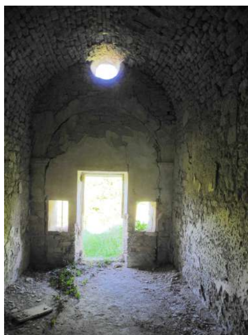
vue de la nef côté est depuis l'autel de l'ancienne église situé à l'ouest
