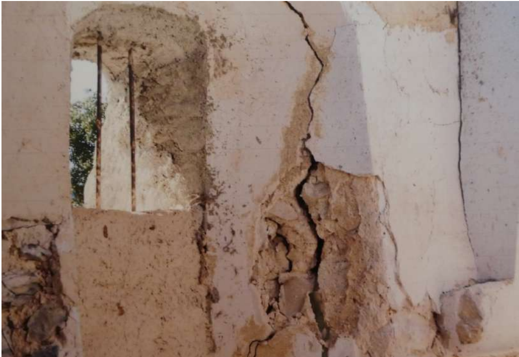
Intérieur de la chapelle avant les travaux de restauration
