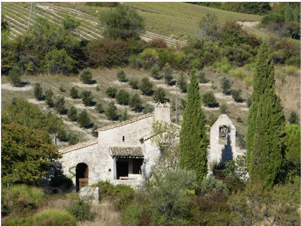
L'ensemble des bâtiments restants, avec à gauche le gîte rural actuel et à droite le clocheton de la chapelle St-Laurent.
