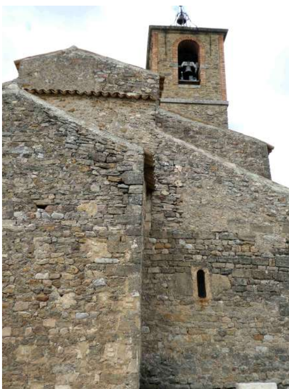
Aperçu de la façade est
