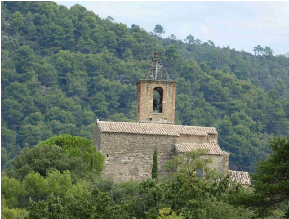
Aperçu depuis le sud près de la route venant de Faucon
