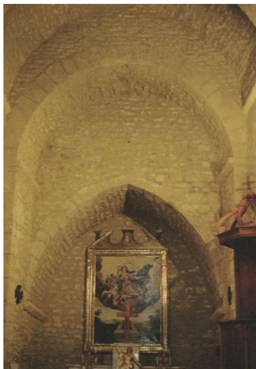
Aperçu de la nef
