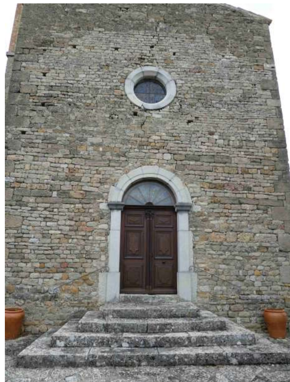
le portail sur la façade ouest
